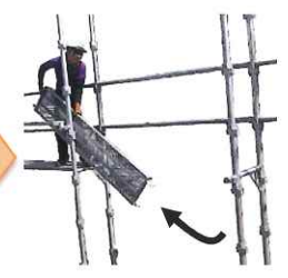
作業床を手前に引上げる
