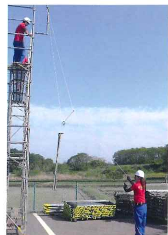
③ 吊縄(6mm)方式による 足場部材の受け渡し
