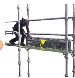
作業床を立て起こす
