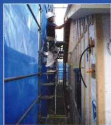
(施工例) 切妻ダンダン
